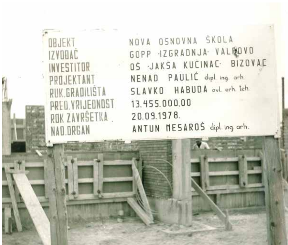
Na gradilištu buduće osnovne škole postavljena je velika ploča na kojoj je moguće pročitati osnovne podatke o gradnji škole (arhiva škole)
