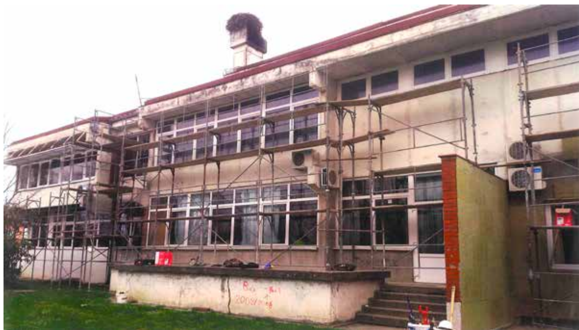
Postavljena skela za početak radova obnove fasade škole (arhiva škole)
