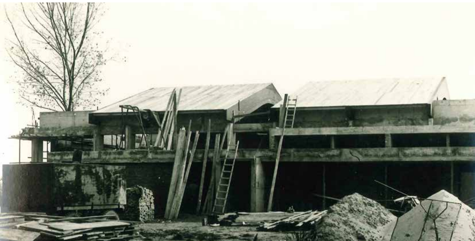
Završetak izgradnje športske dvorane (arhiva škole)
