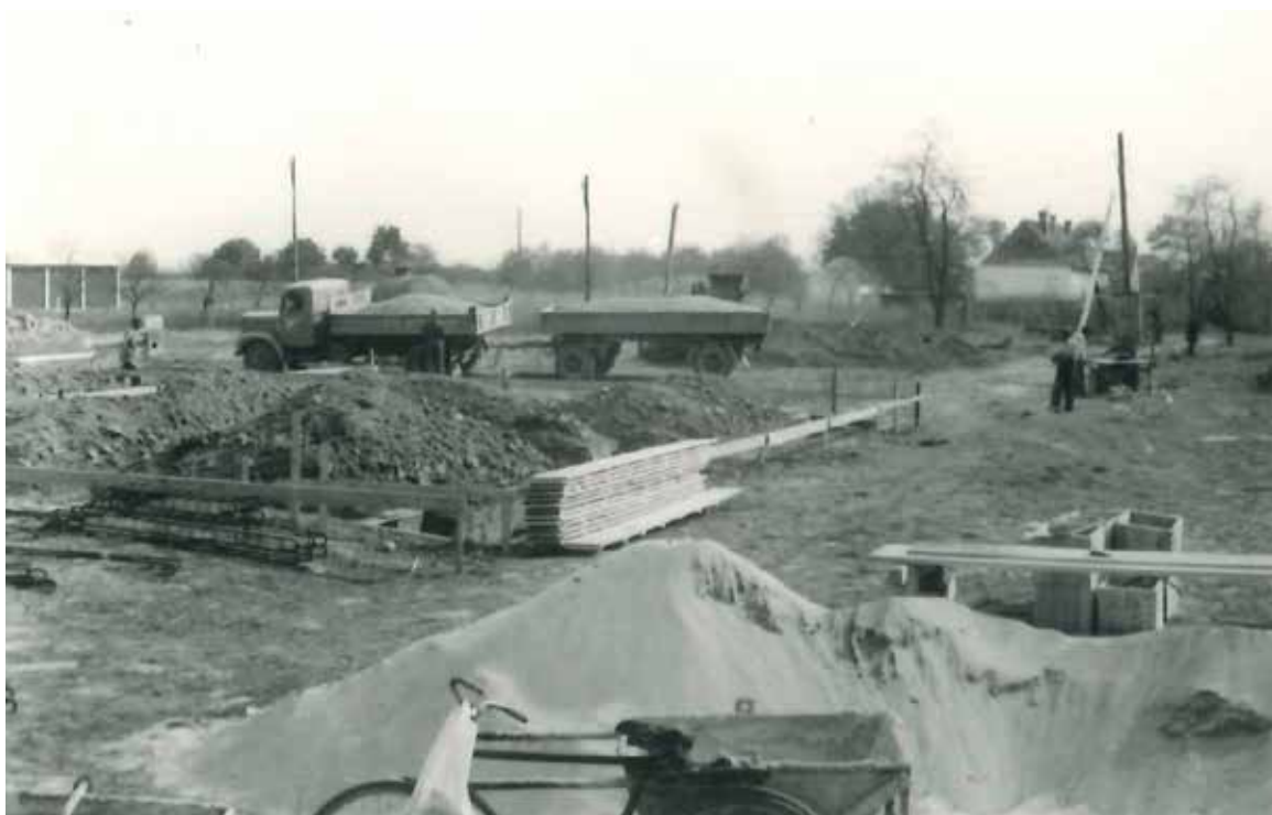
Počeci gradnje nove škole u Bizovcu (arhiva škole)
