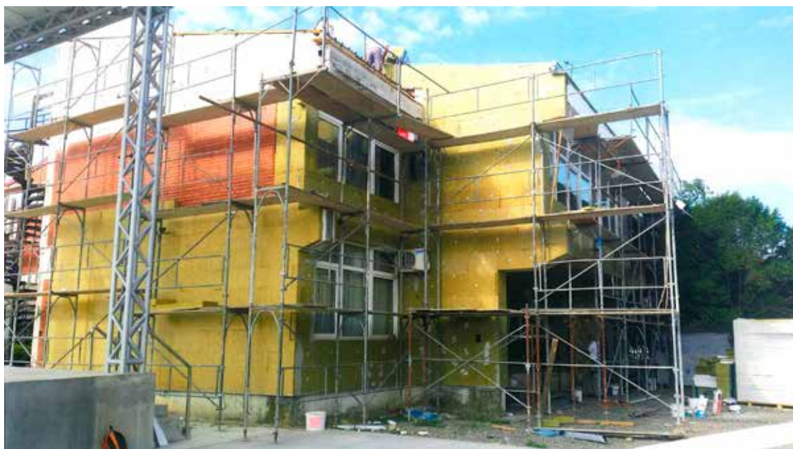
Postavljanje toplinske izolacije (arhiva škole)
